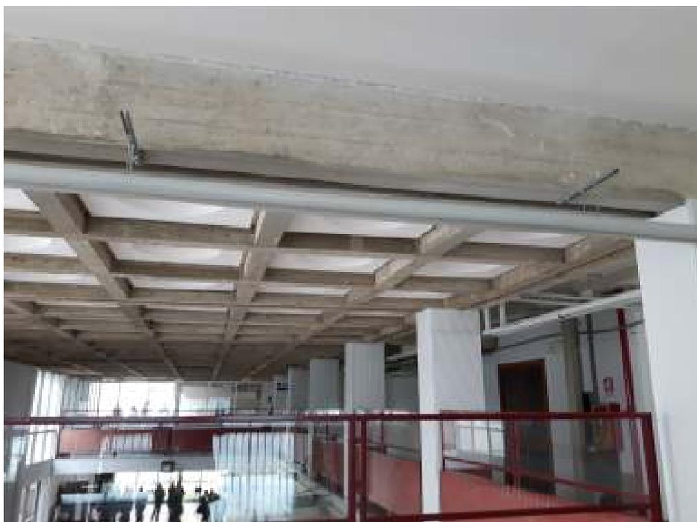
**Figura 9:** Elementi in gesso inseriti nel solaio a cassettoni
