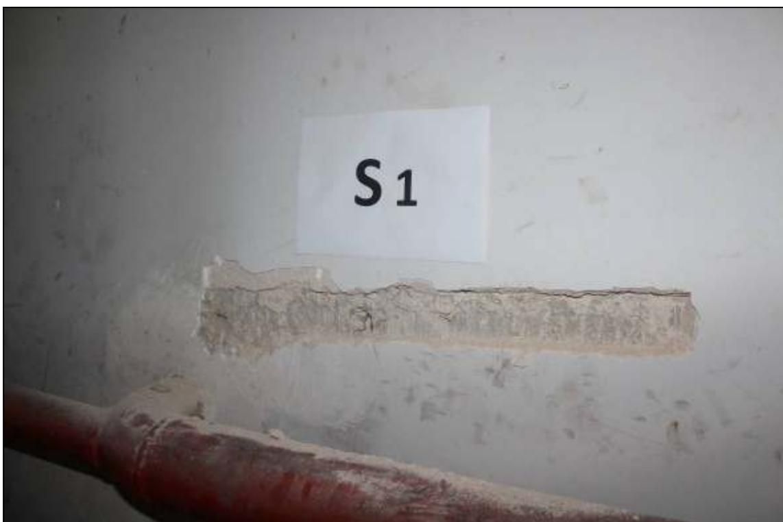
**Figura 1:** Saggio S1 - Piano Terra: Pilastro 47 - Parete in c.a.
