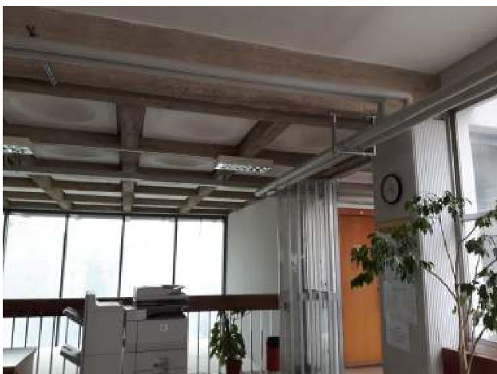
**Figura 10:** Elementi in gesso inseriti nel solaio a cassettoni
